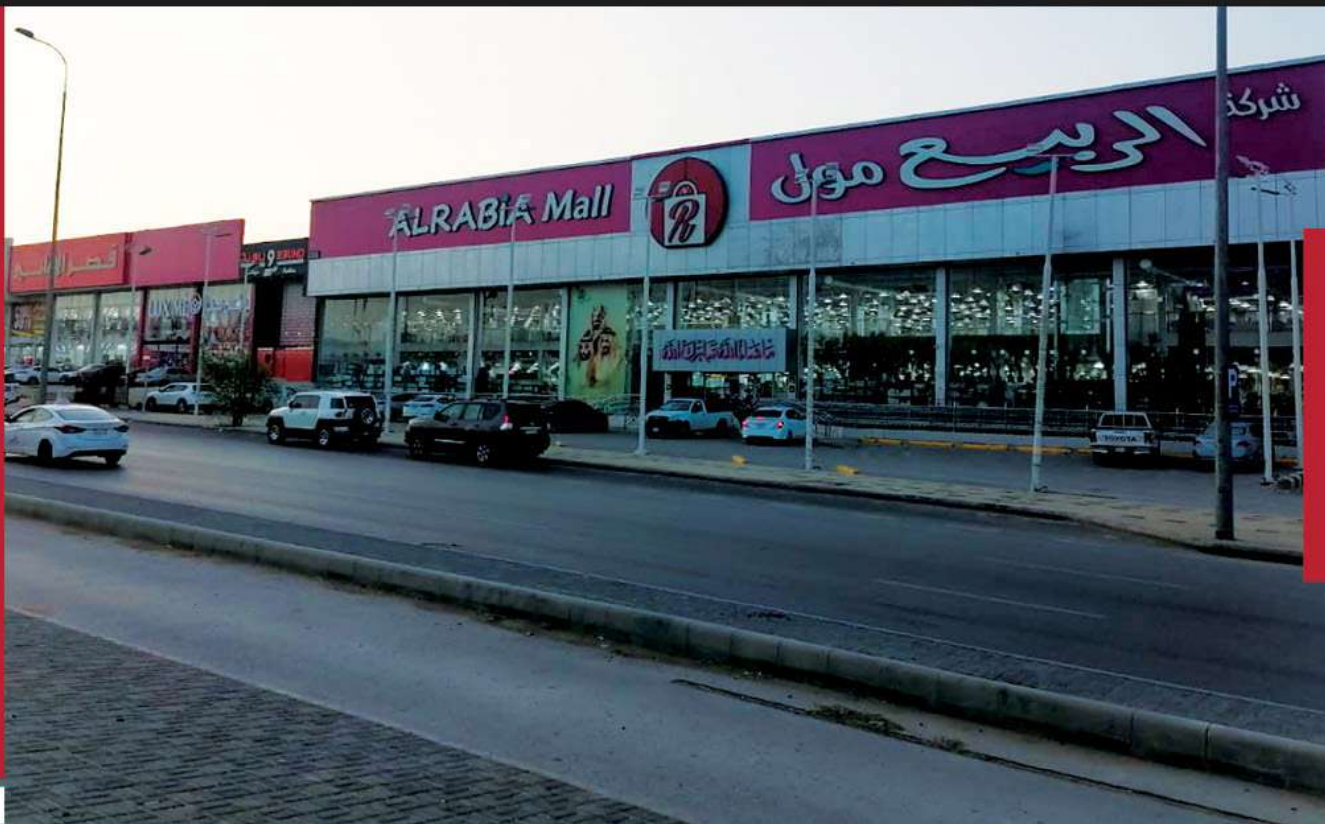
مبنى تجاري مكتبي - عقارات الصالحية
